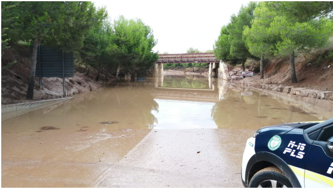
Acceso sur al Port de Sagunt cortado por las inundaciones (Imagen: LEVANTE-EMV)
